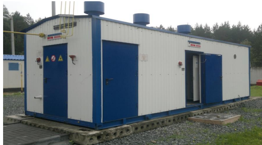
Опытный образец «ТОТЭ ЭХГ-1500» ИВТЭ, НПО «Центротех (Россия), на промплощадке ГРС-4 ООО «Газпром трансгаз Екатеринбург»
