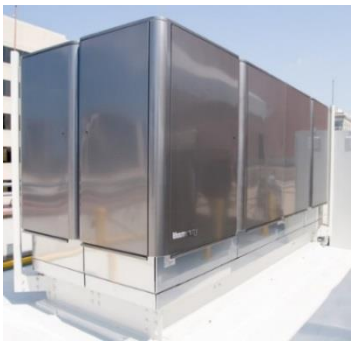
Энергетические модули (серверы) 100 кВт «Bloom Energy» (США) (слева) и электростанции мегаваттного класса на их основе.
