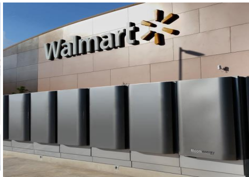
Энергетические модули (серверы) 100 кВт «Bloom Energy» (США) (слева) и электростанции мегаваттного класса на их основе.
