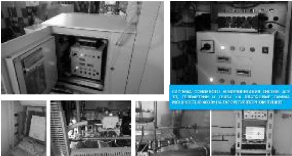
ЭУ «ГАММА» 400-600 Вт АО «ГК ИнЭнерджи» (Россия) на ГРП РС4 «Газпром трансгаз Казань»
